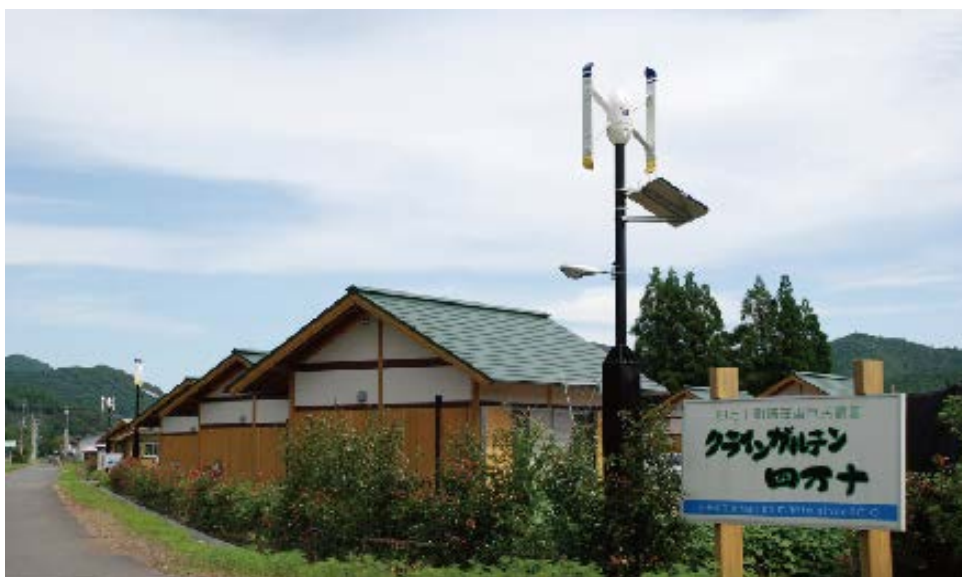
風力発電機と太陽光発電のハイブリッド発電システム
